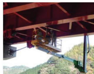
橋梁の点検状況
