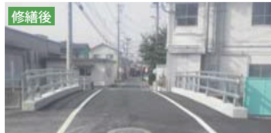
橋梁の修繕状況
