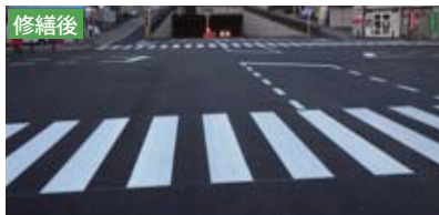
舗装の修繕状況
