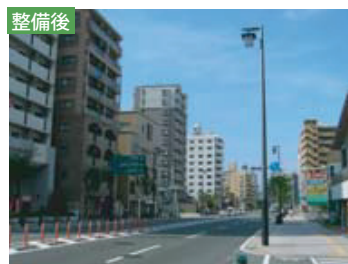
無電柱化 [(都) 堅粕箱崎線]
