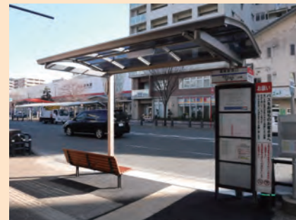
市による上屋・ベンチの設置(箱崎駅西口)
