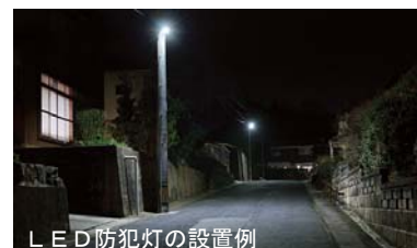
LED防犯灯の設置例
