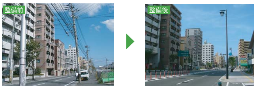
無電柱化[(都)堅粕箱崎線]
