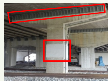
橋りょうの耐震補強
