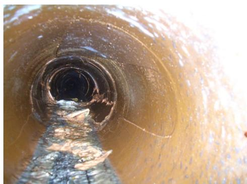
地震により破損した管渠(西戸崎地区)
