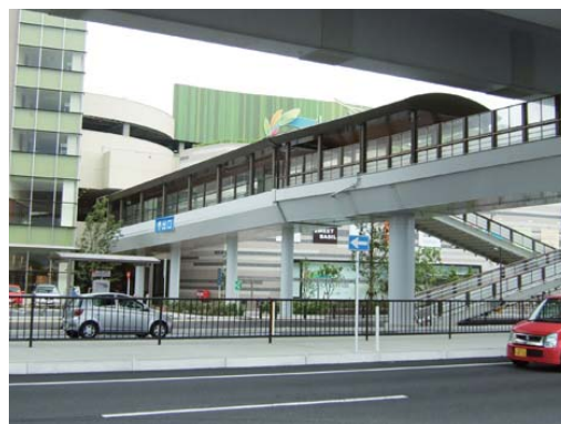
橋本駅に繋がる歩道橋
