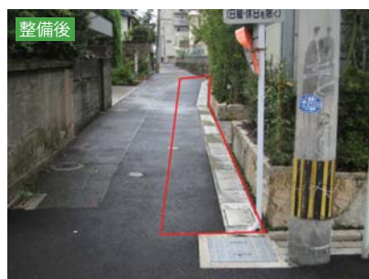
狭あい道路の整備状況
