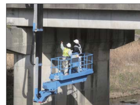
橋梁の点検状況
