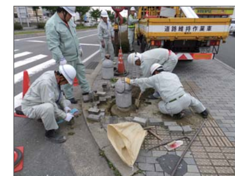
道路施設の補修状況
