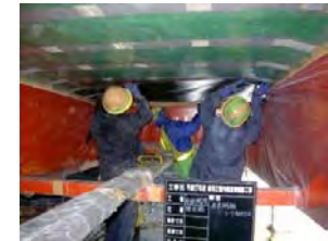
炭素繊維シートによる補修
