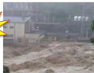
【豪雨時の水力発電所の状況】
