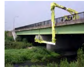
橋梁点検車を使った橋梁点検
