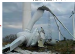
【風車落下事故の状況】
