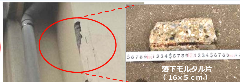
剥離落下が発生した校舎外壁
