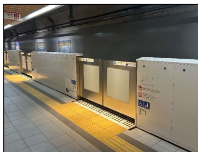
ホームドアの設置
