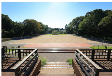
▲温室前広場全景
