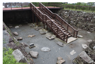
調査着手前の天守台内側(穴蔵)
