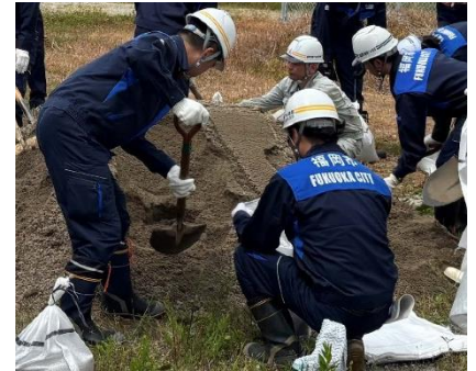
土のう製作の様子
