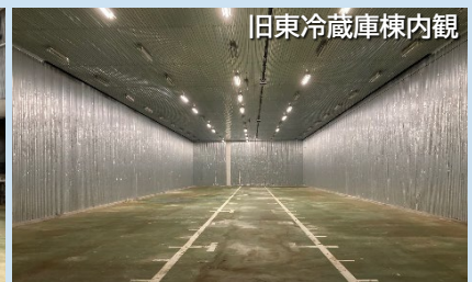
旧東冷蔵庫棟内観
