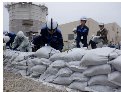
土のう積みの様子
