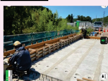
【立会状況（地覆型枠検測）】
