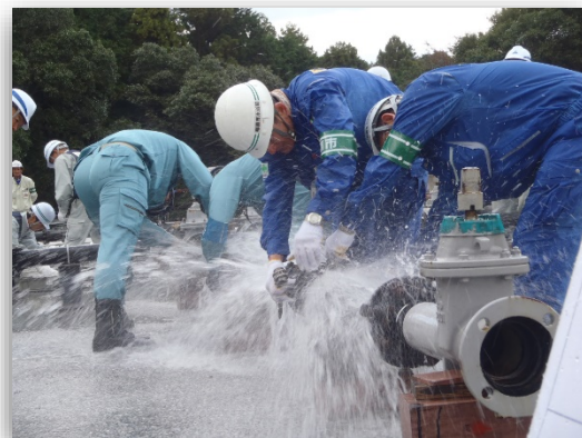
水道技術研修所での応急復旧訓練
