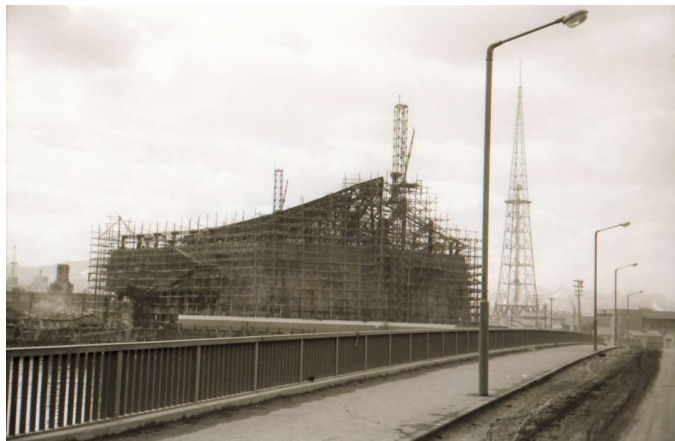
建設中の福岡市民会館（昭和 38 年撮影）
