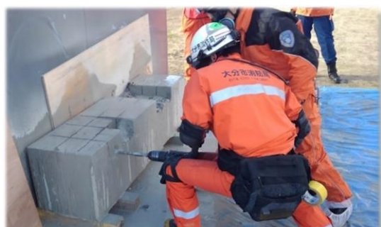
③出入口のないコンクリート造の建物を破壊し、出入口を作成する訓練（「ブリーチング」＝サイトC）
