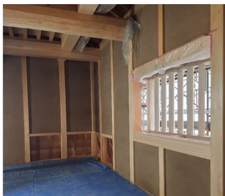
( 現在の潮見櫓1階内部 )
