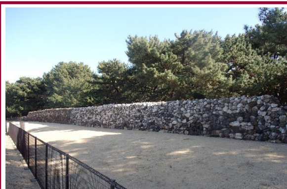
改修前(防塁は柵の中で遠くから見学)
