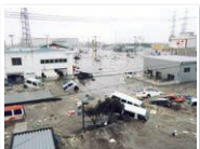
多賀城市の中心地の 津波被害状況
