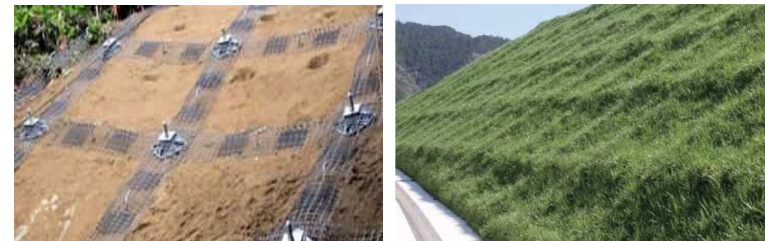
写真4-1 GTフレーム受圧板工法（施工中、緑化後）
