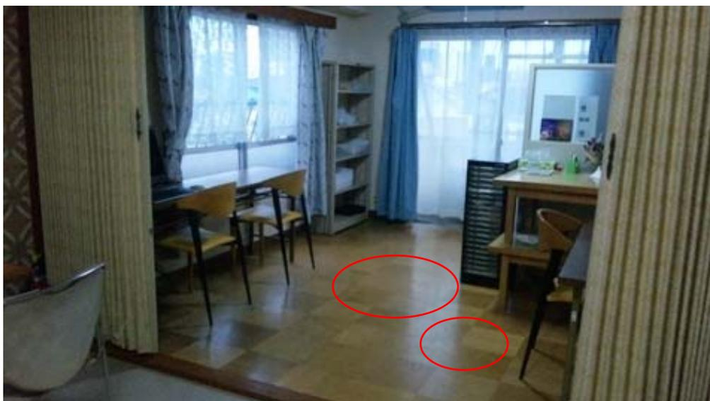
床板の老朽化に伴い、頻繁に通る中央部、作業台前の赤丸内部分が5～10mmほど沈み、床板が割れ怪我をする恐れもあった。その部分を通らないように、移動しなければならなかったし、また、いつ割れるのではと不安気持ちで活動をしていた。
