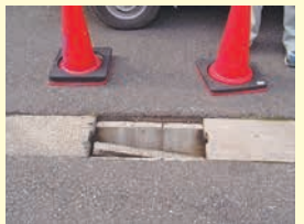
側溝・側溝蓋の破損
