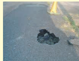
舗装の破損、くぼみ、穴
