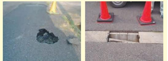
舗装の破損、くぼみ、穴 側溝・側溝蓋の破損
