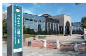
■ プレートの設置 (単独柱タイプ)
