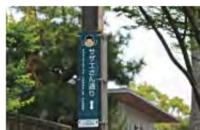
● プレートの設置 (共架タイプ)
