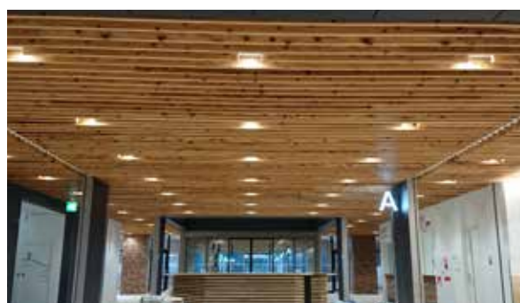
防火木材の施工状況 鹿児島県奄美市庁舎市民窓口 (平川木材工業提供)
