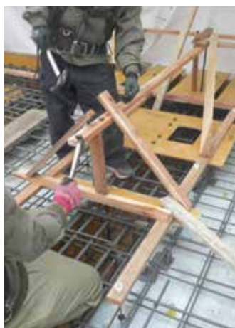
写真5.1 アンカーセットの据付（WIL・BU 山王の施工状況）
