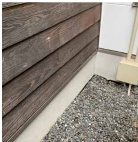
写真 4.2.6.9 砂利敷による跳ね返り雨水対策
