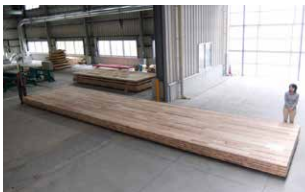
写真 3.4 CLT 原版の製作実大 3.0m × 12.0m (銘建工業(株)提供)
