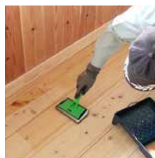
写真 4.2.6.3 含浸系塗料の施工
