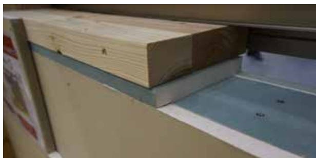
写真 1 時間耐火構造 (t21 強化せっこうボード 2 重張り)
