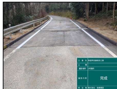
【林道の復旧状況】
