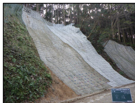
【既存林道の施設補強工事】
