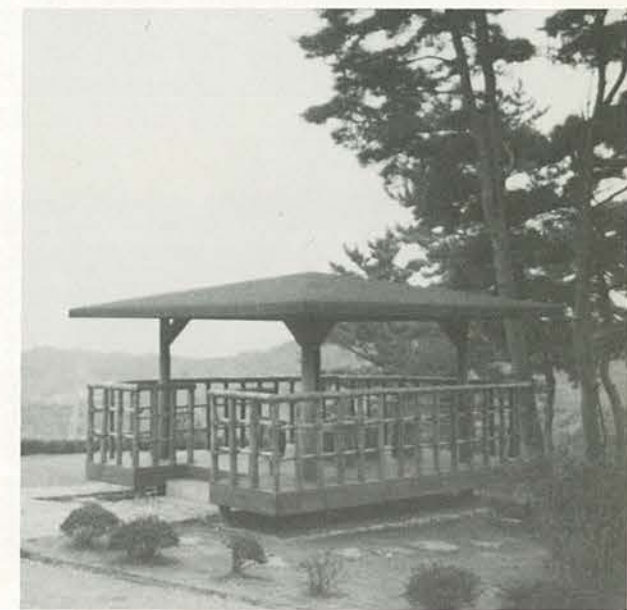
●つり橋休憩所
