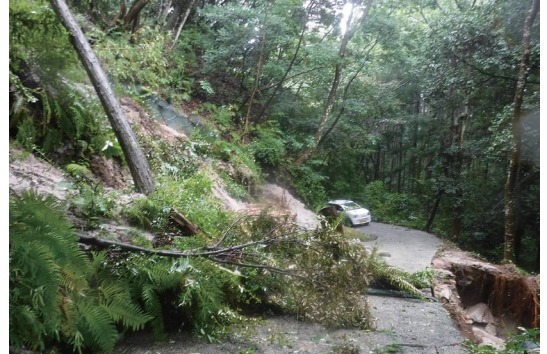
集中豪雨による林道の土砂災害
