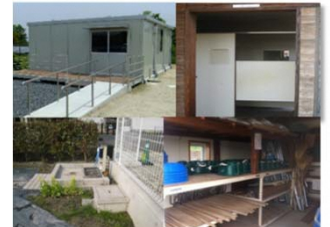
附帯施設：休憩所、衛生設備（トイレ、洗い場）農機具格納庫
