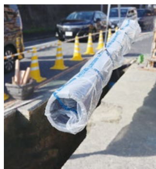
ポリエチレンスリーブを装着した水道管
