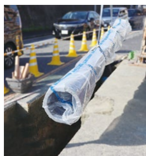
ポリエチレンスリーブを装着した水道管
