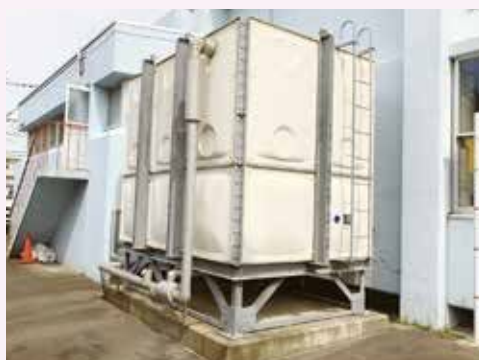
一般的な共同住宅等に設置されている貯水槽
