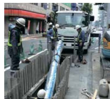
水道管の工事の様子
