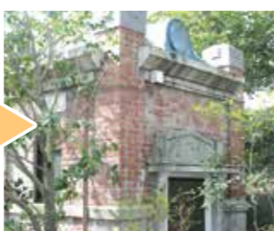
○現在、植物園に残っている平尾浄水場の建物の一部
