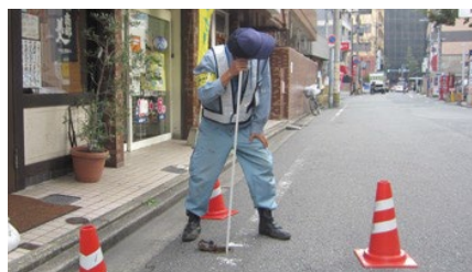
音聴棒による漏水調査
