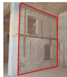
耐震壁設置後
