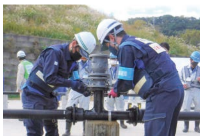
応急復旧訓練
