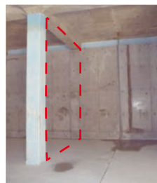
耐震壁設置前
