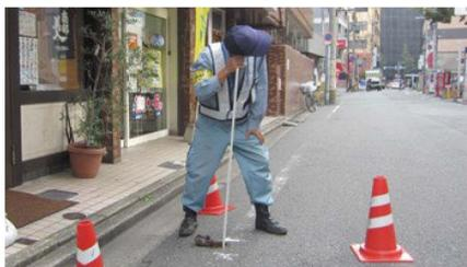
音聴棒による漏水調査
