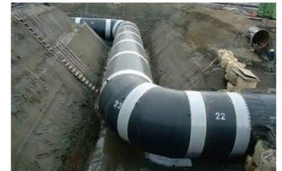
鋼管(耐震管)による布設状況
