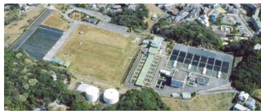
高宮浄水場(昭和35年建設)
