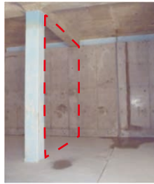
耐震壁設置前
