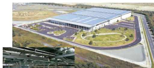
海の中道奈多海水淡水化センター (愛称:まみずピア)
