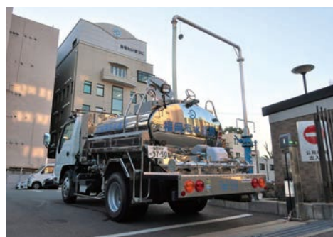
注水設備と給水車
