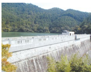
福岡市植物園に残る 平尾浄水場跡 (配水池の点検用通路入口)
