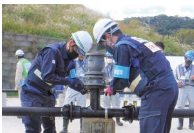
応急復旧訓練
