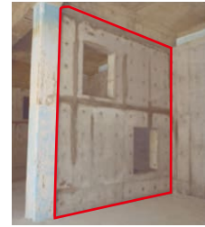
耐震壁設置後
