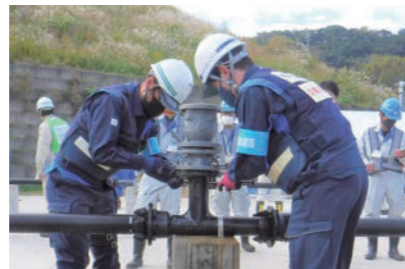
応急復旧訓練
