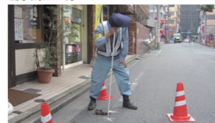
音聴棒による漏水調査
