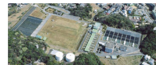
高宮浄水場(昭和35年建設)
