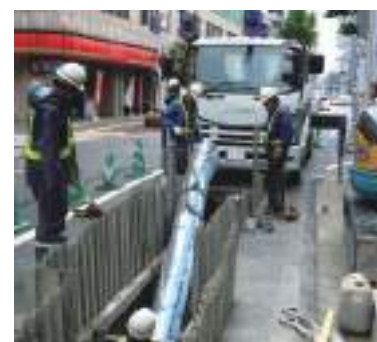
水道管の工事の様子
