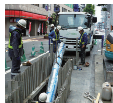
水道管の工事の様子
