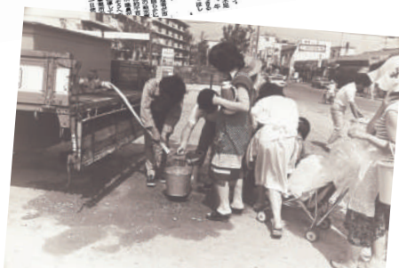
しょうすい し 昭和53年 給水車から給水を受ける市民の様子
