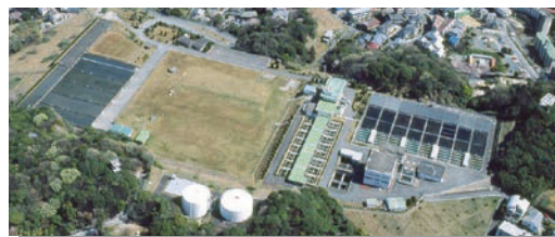
高宮浄水場(昭和35年建設)
