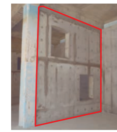
耐震壁設置後
