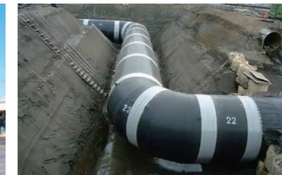
鋼管(耐震管)による布設状況 写真提供：日本水道鋼管協会
