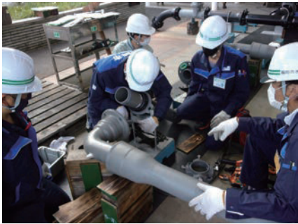
水道技術研修所
