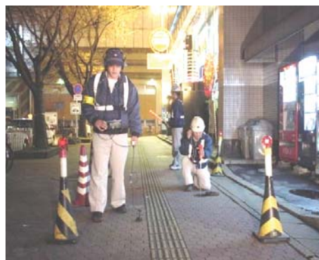
调查漏水时的情景
