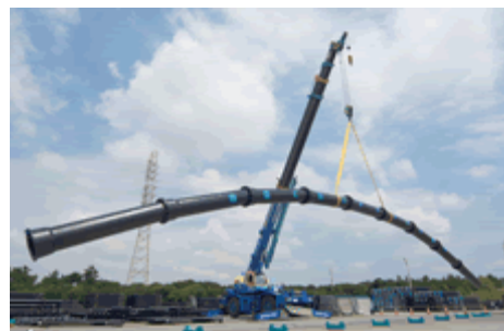
既能够抵御地震时的外力(压缩和拉伸)，又可以随从地盘的变形而柔软变化的抗震管道。
