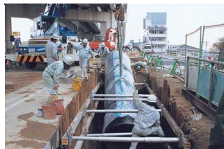
供水管道架设工程的情景
