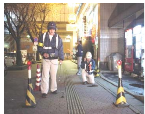
漏水調査の様子
