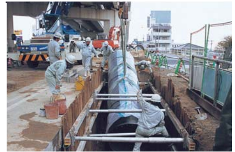
配水管の布設工事の様子
